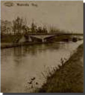
De vooroorlogse betonnen brug van Ravels dateert uit 1908.
