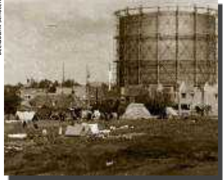
De gasketel wordt in 1972 afgebroken. Vandaag bevindt het gebouw van de Lokale Politie Schoten zich op het terrein.
