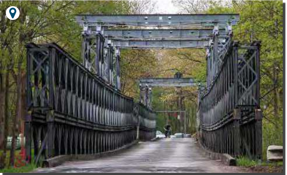
De baileybrug in Mol vandaag. De baileybrug van Mol aan De Maat is een dubbele baileybrug, aan elkaar verbonden via het 'Postels eilandje'. De restanten van de brug die begin WOII werd opgeblazen zijn nog goed te zien. De brug is erkend als bouwkundig erfgoed, de site waar de brug ligt is belangrijk cultuurhistorisch landschap.
